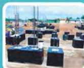
กันซึมชั้นใต้ดิน
