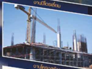
งานโครงสร้าง
